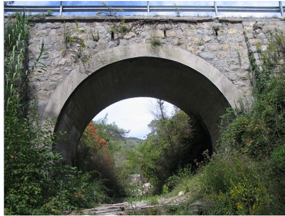
Fig. 2.2.1. Ponte monocampata stradale in calcestruzzo
