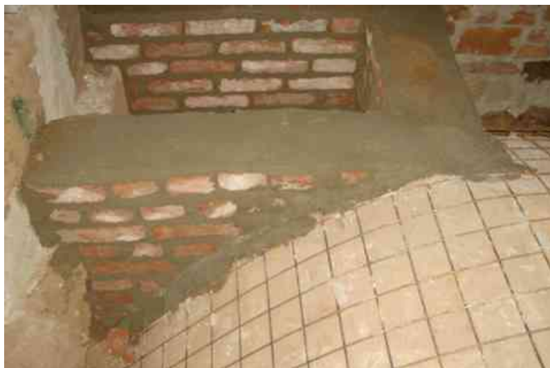
Fig. 1.6.3.1. Consolidamento di una volta con frenelli (immagine tratta da: http://www.voltestella.it/luso-dei-frenelli-nel-consolidamento-delle-volte/ )
