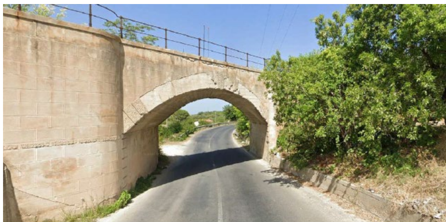
Fig. 2.4.1. Ponte obliquo ferroviario su sottostante viabilità stradale
