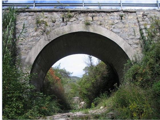
Fig. 2.2.1. Ponte monocampata stradale in calcestruzzo
