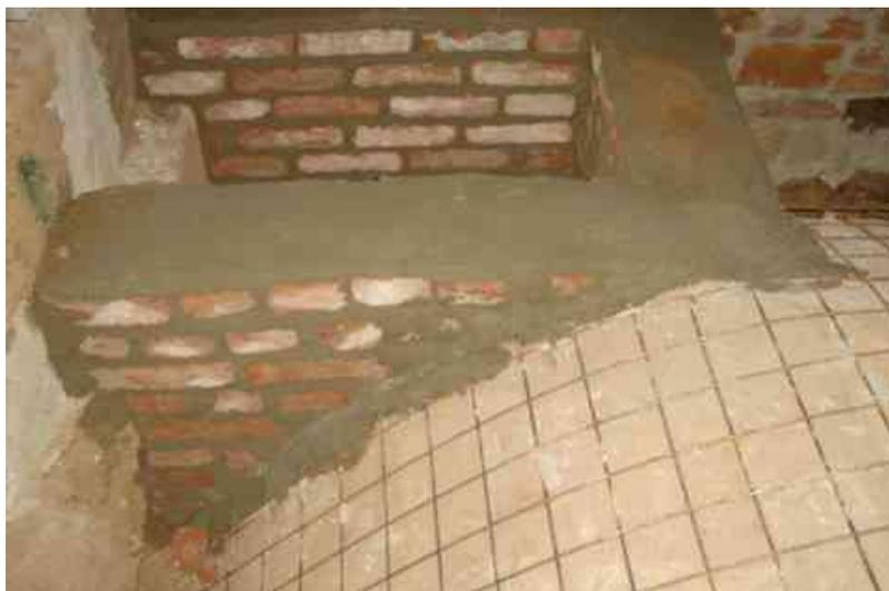
*Fig. 1.6.3.1. Consolidamento di una volta con frenelli
