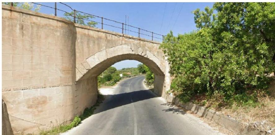
*Fig. 2.4.1. Ponte obliquo ferroviario su sottostante viabilità stradale*
