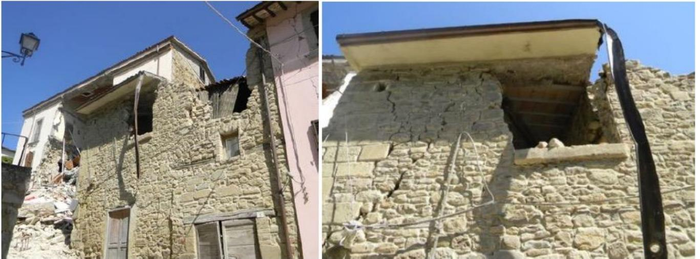
*Fig. 10. Disgregazione di un edificio in muratura (da [3])*
