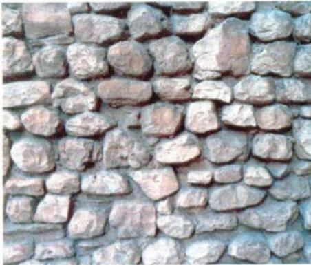
Fig. 1 - Muratura in pietraforte fortemente degradata per erosione e decoesione dei giunti di malta. Il degrado avanzato delle malte può provocare il distacco dei blocchi lapidei con instabilizzazione e caduta degli stessi.
