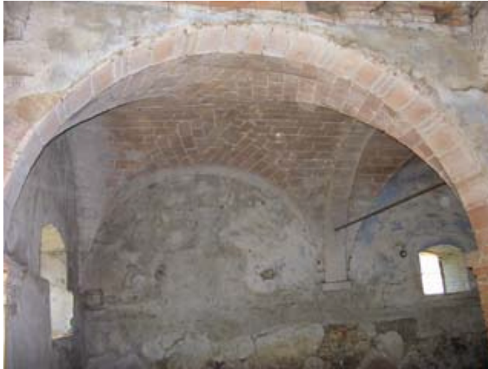
Fig. 6. Crociera d'angolo: settore laterale.
